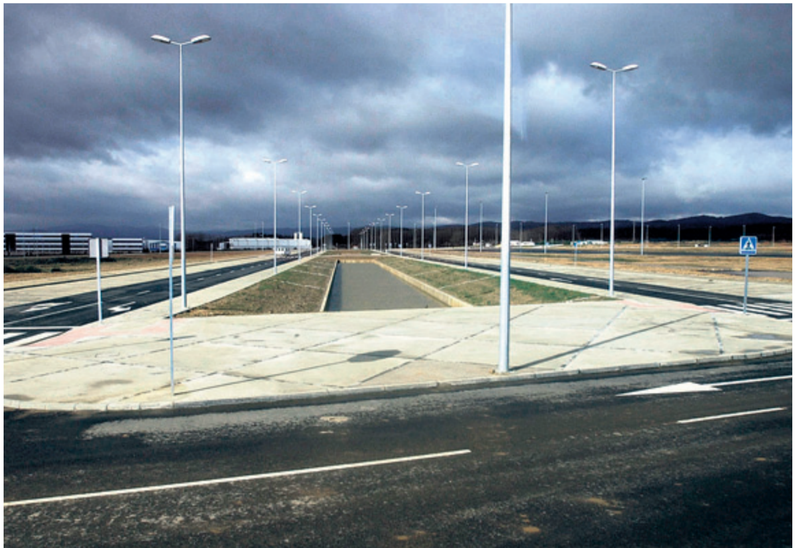
La empresa TerraTerm ya ha realizado las primeras instalaciones geotérmicas en el polígono industrial del Bayo. GAZTELU
